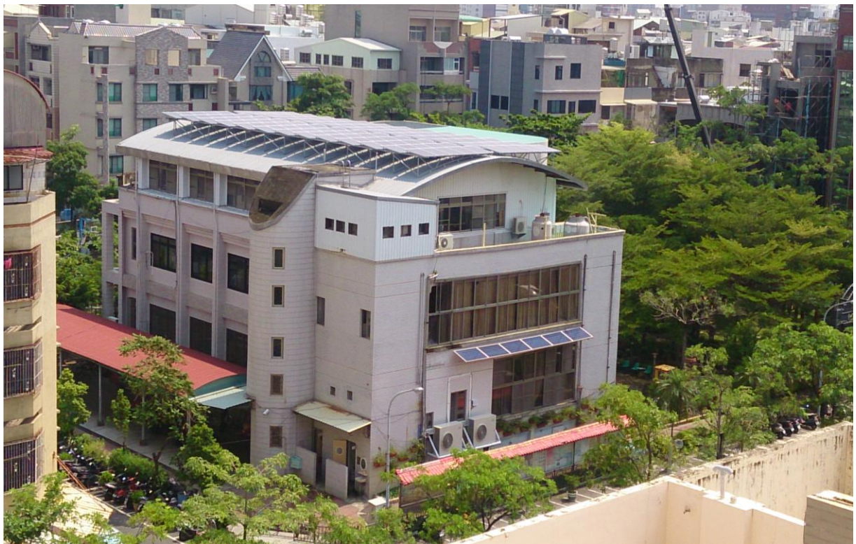
金華社區活動中心屋頂架設太陽能光電板併聯台電、太陽能充電站等，相當多元。
