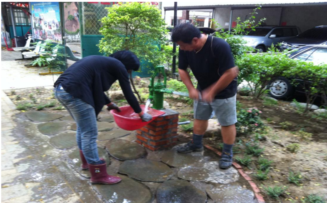
小孩新玩藝，大人舊回憶的「節水防災」大水協汲水設備
