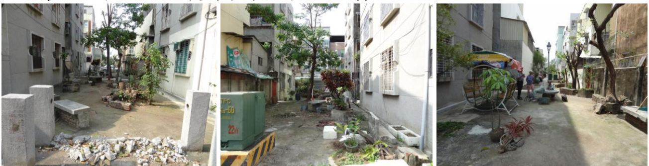
國宅區域之鄰棟空間環境紊亂，原有設施老舊安全堪虞，樹木板跟隆起，環境雜亂。
